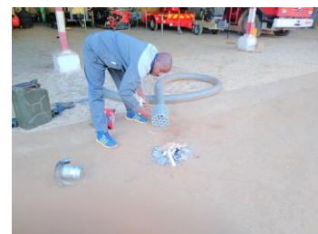
A droite : Réalisation de la ligne d'aspiration
